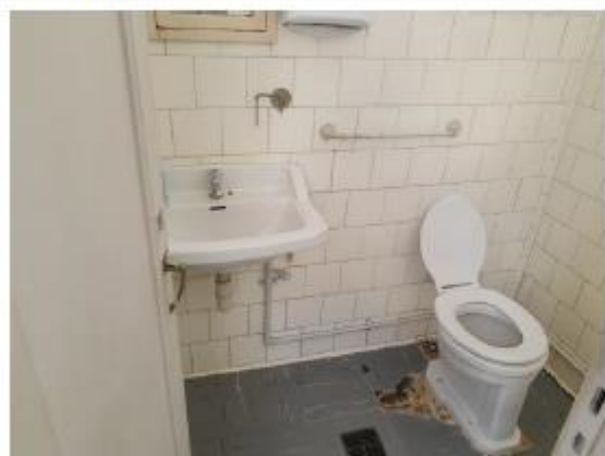
Vista interna - Sanitário
