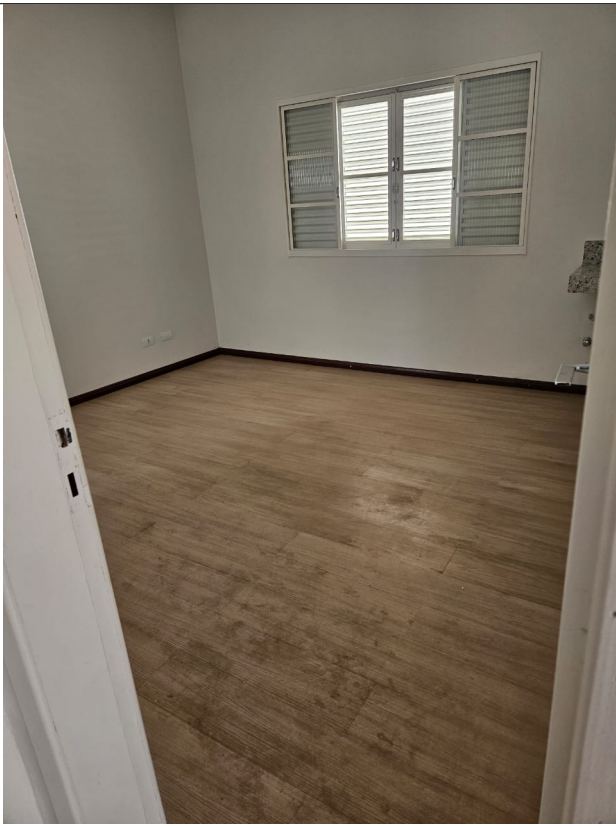
Vista Interna - Salas - 2º Pavimento
