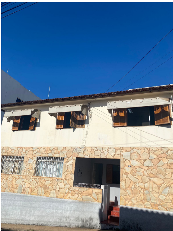
Foto dos toldos para substituição.
